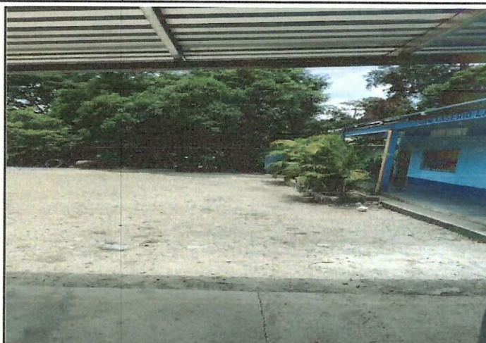
Foto 2: Mejoramiento de Losa de Patio.
